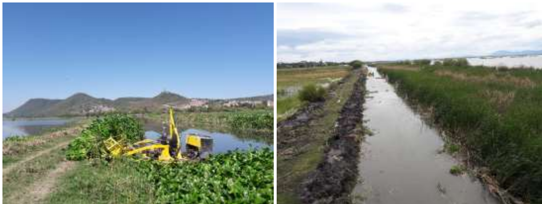
Trabajos en el canal de Ballesteros (octubre-noviembre de 2017)
